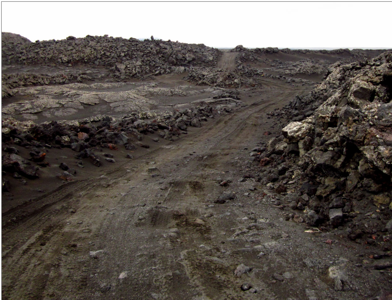
В Исландии дорога в лавовых полях пробивается грейдером.
